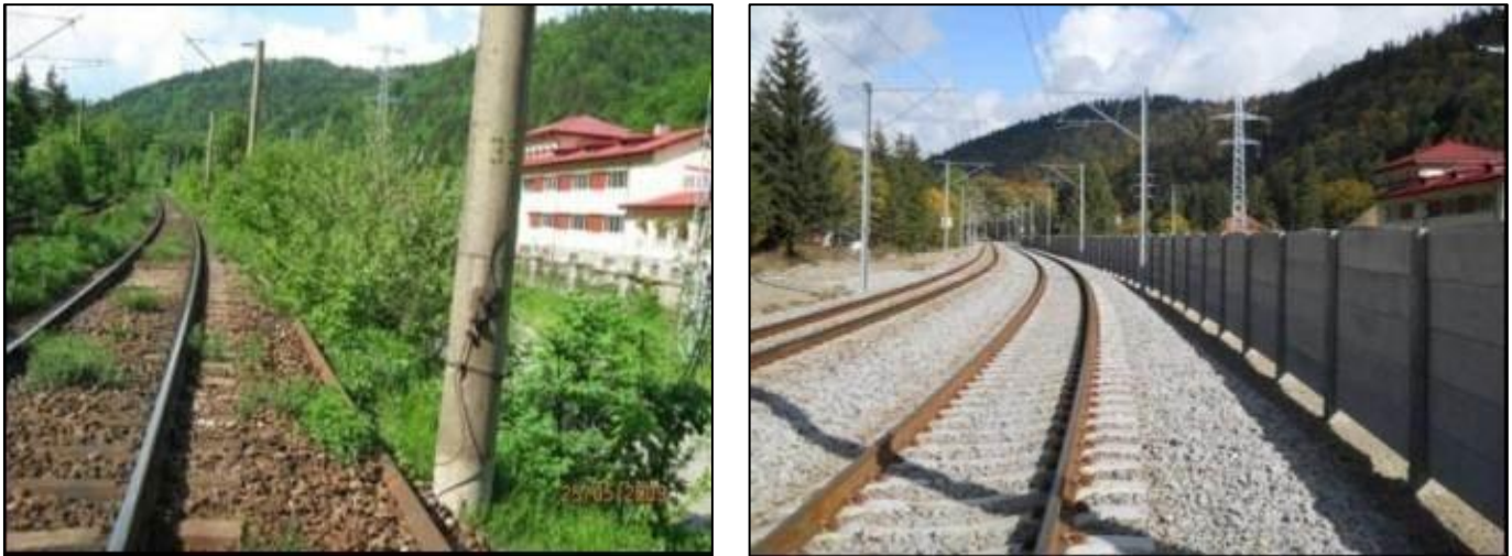
Figurile 5,39, 5,40- Exemplu de linie de cale ferată înainte și după reabilitare
