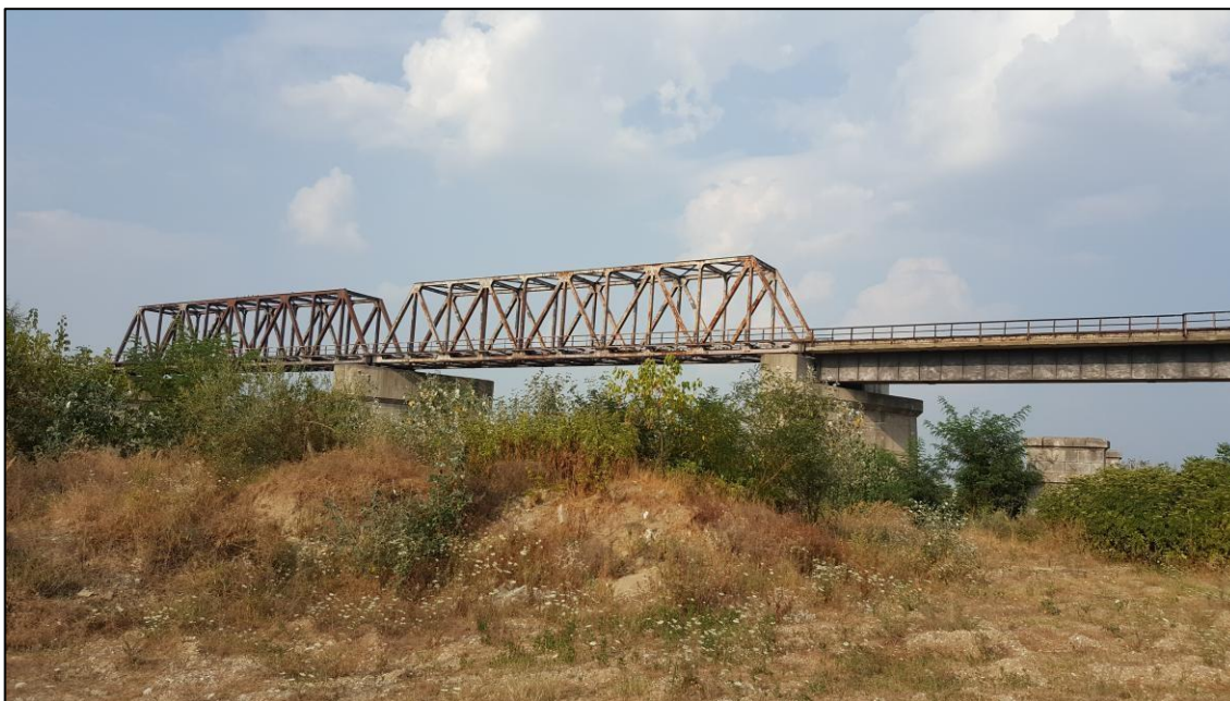
Figura 5,77 - Actualul pod feroviar peste râul Argeș de la Grădiștea, nefinalizat Sursa: Ministerul Transporturilor
