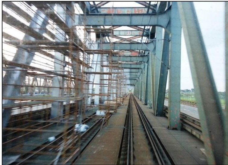
Figura 5,9 - Podurile dunărene – lucrări în curs. Modernizarea podurilor va avea impact pozitiv asupra duratei călătoriei pe sectorul feroviar București - Constanța
