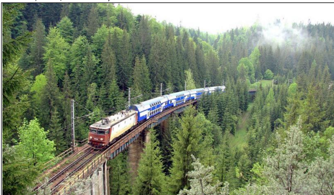
Figura 5,84 - Sector dificil de cale ferată între Lunca Ilvei și Gradinița (viaducte și tuneluri în Munții Bârgăului)
