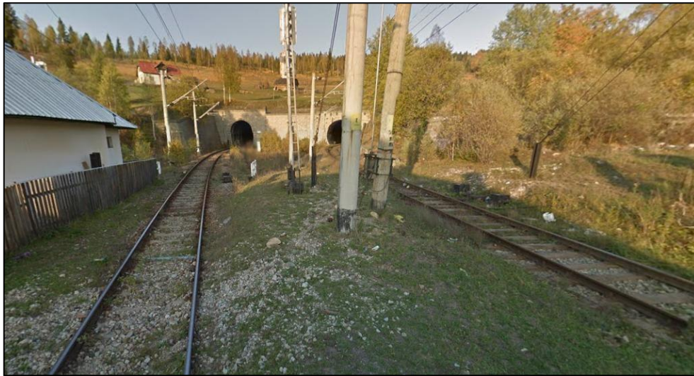
Figura 5,85 - Calea ferată dublă electrificată în zona tunelurilor Mestecăniș (traversarea Carpaților Meridionali)
