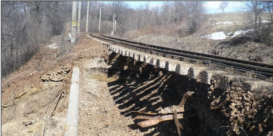
Figura 5,81 - Alunecare de teren care a afectat coridorul TEN-T Core în zona Balota Sursa: Ministerul Transporturilor
